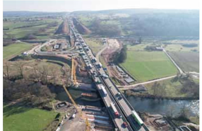
Blick auf die Anschlussstelle Pforzheim-Ost (Bildquelle: Autobahn GmbH Niederlassung Südwest)
